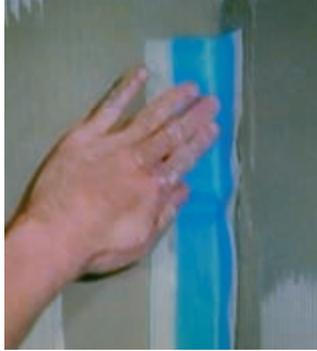
Für Innen- und Außenecken, Kanten sowie an Rohrdurchführungen können die Produkte aus dem OTTOFLEX-System verwendet werden (Innen-/ Außenecke, Boden- und Wanddichtmanschette sowie Dichtband). Diese müssen aber im Überlappungsbereich dicht verklebt werden. Das Einbringen dieser OTTOFLEX Produkte kann vor oder nach Verarbeitung der OTTOFLEX Abdichtbahn erfolgen.
