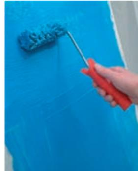
Beim Auftrag mit einem kurzflorigen Lammfellroller wird die zweite Lage der OTTOFLEX Flüssigfolie quer zur ersten aufgetragen, um eventuelle Fehlstellen in der Schicht zu vermeiden.
