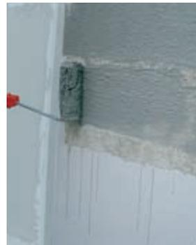
Wird die OTTOFLEX Dichtungsschlämme mit einem kurzflorigen Lammfellroller aufgetragen, sind drei Schichten nötig, um eine Trockenschichtstärke von 2 mm zu erhalten.
