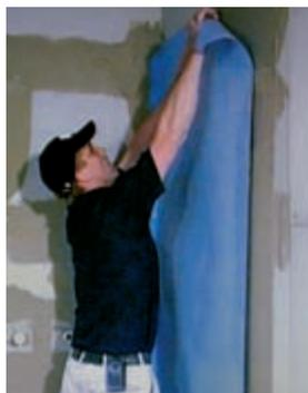
OTTOFLEX Abdichtbahn vollflächig in den Kleber eindrücken. Zum Eindrücken empfiehlt sich die Glattseite der Zahnpachtel oder eine Glättspachtel, die unter Druck schräg über die OTTOFLEX Abdichtbahn geführt wird. Luft einschließen müssen unbedingt vermieden werden.
