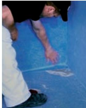
Zur Fliesenverlegung im Dünnbetverfahren ist der Fliesenkleber direkt auf die OTTOFLEX Abdichtbahn aufzutragen. Darauf sind die Fliesen vollsatt zu verlegen. Die Wahl des Fliesenklebers ist auf die Belagsart und -beanspruchung abzustimmen.
