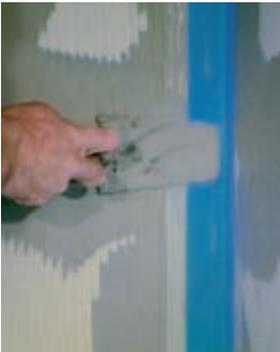
Erst wenn die OTTOFLEX Dichtbahn mit allen Überlappungen, Ecken und Anschlüssen dicht verklebt ist, kann mit dem Aufbringen des Belags begonnen werden. Eine Wartezeit ist nicht erforderlich.
