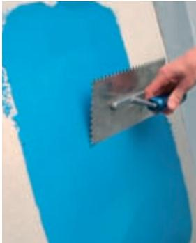
Die OTTOFLEX Flüssigfolie kann mit einer Glättspachtel aufgetragen werden, wobei darauf zu achten ist, dass die gesamte Fläche gleichmäßig beschichtet ist.
